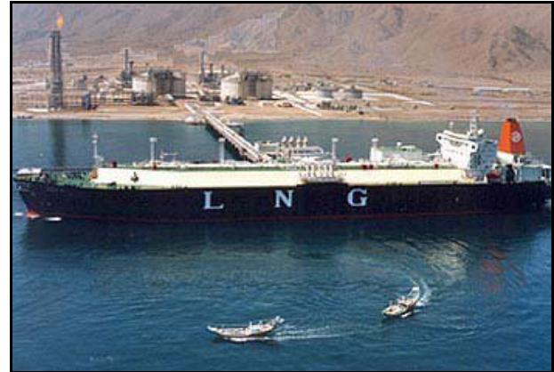
LNG Storage Terminal and Marine Dock
