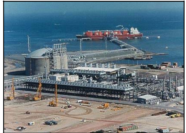
LNG Plant Under Construction
